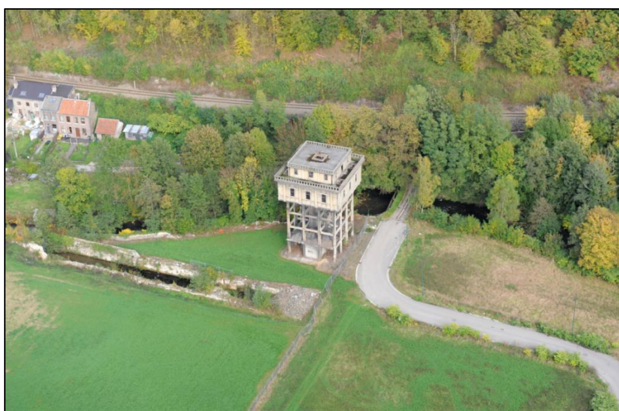
Figure 4 : Vue aérienne du filtre à eau et du bief de dérivation du Hoyoux après travaux de réhabilitation (octobre 2013)
