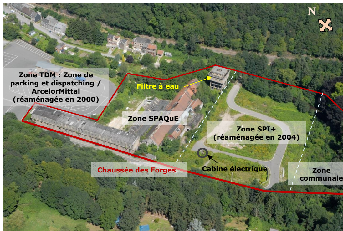
Figure 3 : Vue aérienne du site avant le démarrage des travaux de réhabilitation (Août 2007)
